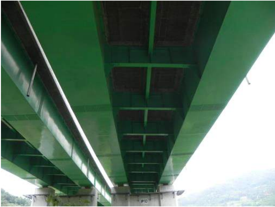
바닥판하면 및 강박스 외부전경
